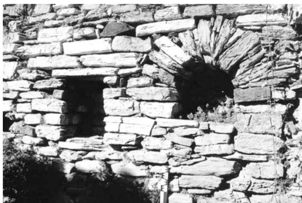
Fig. 29 : *Castrum* de Ventajou, église Saint-Nazaire. Mur M382 : vue détaillée des niches NI6 (à droite) et NI7 (à gauche).
